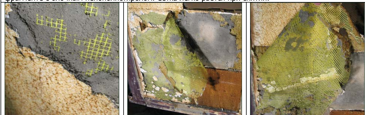
Процесс демонтажа фрагментов системы после 700 циклов воздействия. Состояние сетки на фрагменте с минераловатными плитами. Сетка не рвется при снятии.
