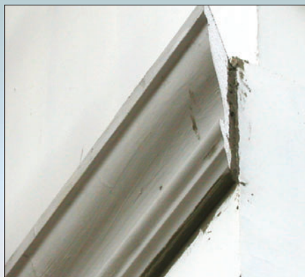
Установка архитектурных элементов на клеевой слой без дополнительного дюбельного крепления и армирования на поверхность теплоизоляционной системы
