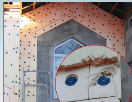
Архитектурные элементы установлены без клеящего состава на дюбельном креплении непосредственно в тело теплоизоляционной плиты
