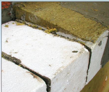
Выполнение архитектурных элементов из «упаковочного» пенополистирола и фрагментов минеральной плиты
