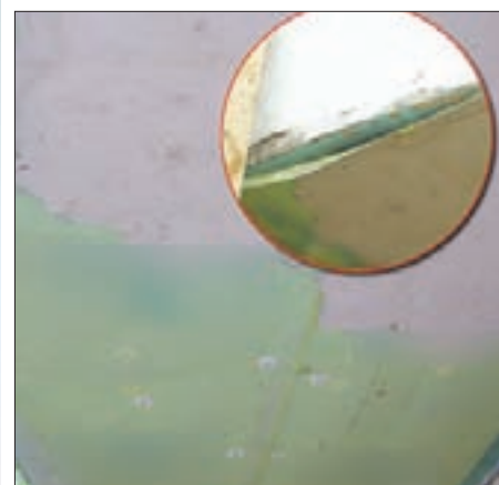
Неправильно установлена армирующая сетка: она находится на плите теплоизоляции или выступает из армирующего слоя; отсутствует необходимый перехлест соседних полотен.
