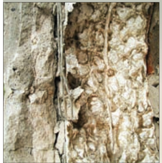
В системе теплоизоляции использовались теплоизоляционные плиты мягкого или «рулонного» типа, с низкой плотностью, непригодные и не предназначенные для систем теплоизоляции «мокрого» типа
